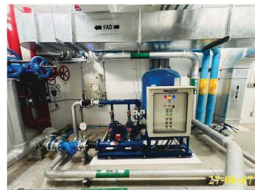
ถังเก็บน้ำ พร้อมเครื่องปั้มน้ำขึ้นตาดฟ้า
