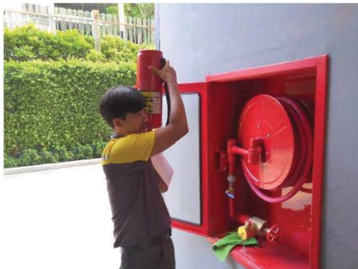
ช่างดำเนินการตรวจเช็คอุปกรณ์ป้องกันและแจ้งเหตุเพลิงไหม้
