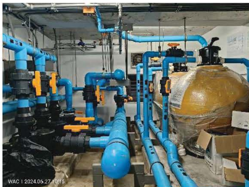
ระบบกรองน้ำสรวายน้ำ
