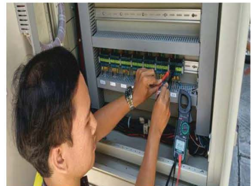
ช่างดำเนินการตรวจเช็คตู้ควบคุมระบบบำบัดน้ำเสีย
